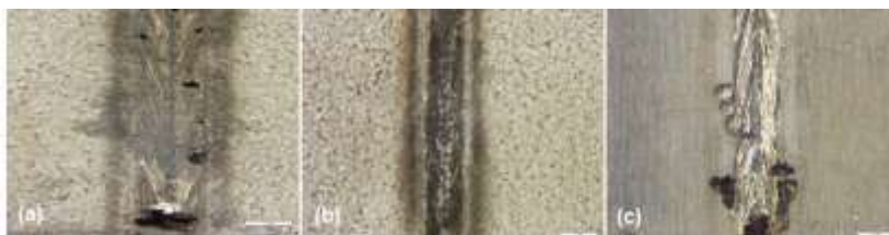
2. ábra. A korróziós tesztelés után megjelenő lyukkorrózió 2000W-on való hegesztett kötések környezetében a) 2304 acél, b) 2404 acél c) 304 acél
