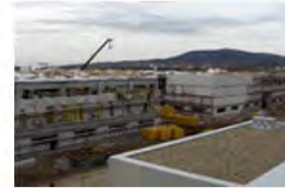
Logisztika és gépszerelő üzem bővítése
